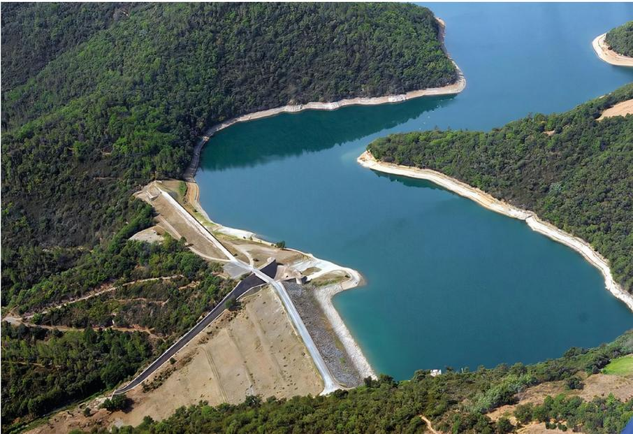
Fig. 13 : Barrage en enrochements et lac de de St-Cassien.
