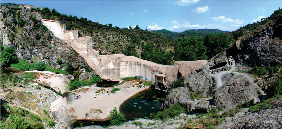
Fig. 14 : Ruines du barrage de Malpasset avec brèche correspondant à la destruction de sa partie gauche et de la culée. Wikimedia Commons, photo Royonx.
