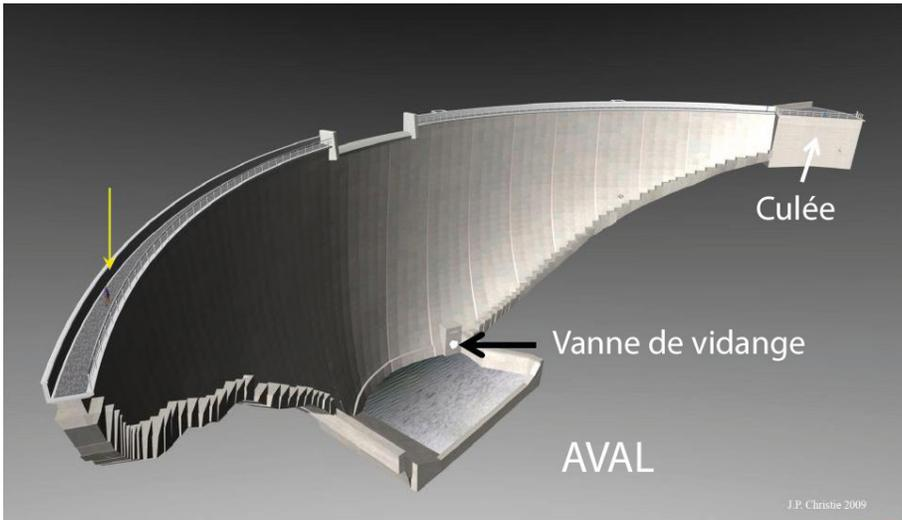
Fig. 7 : Maquette du barrage de Malpasset. Document EDF.
